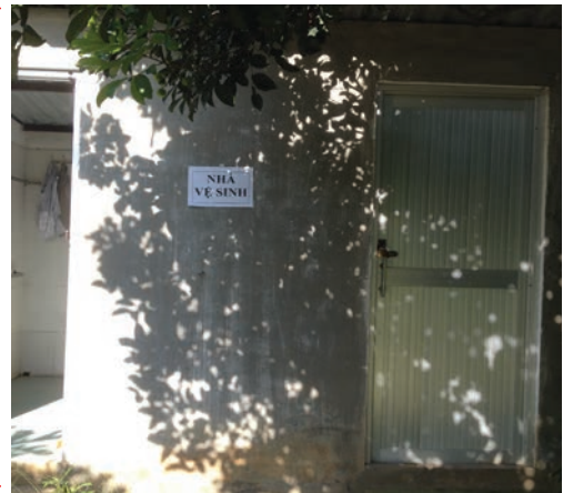
Hình 10. Nhà vệ sinh tự hoại
