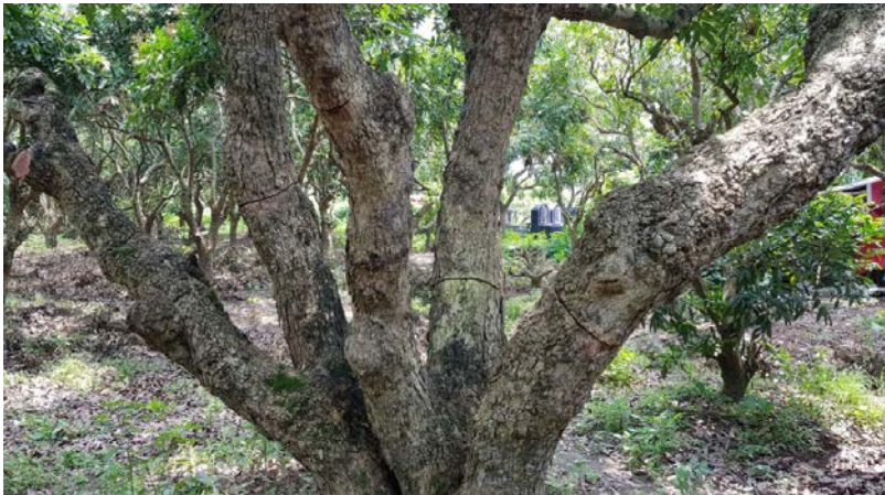
Hình 20. Biện pháp khoan vỏ
