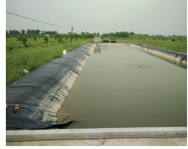
c. Bể nước dùng để cấp nước cho hệ thống tưới
